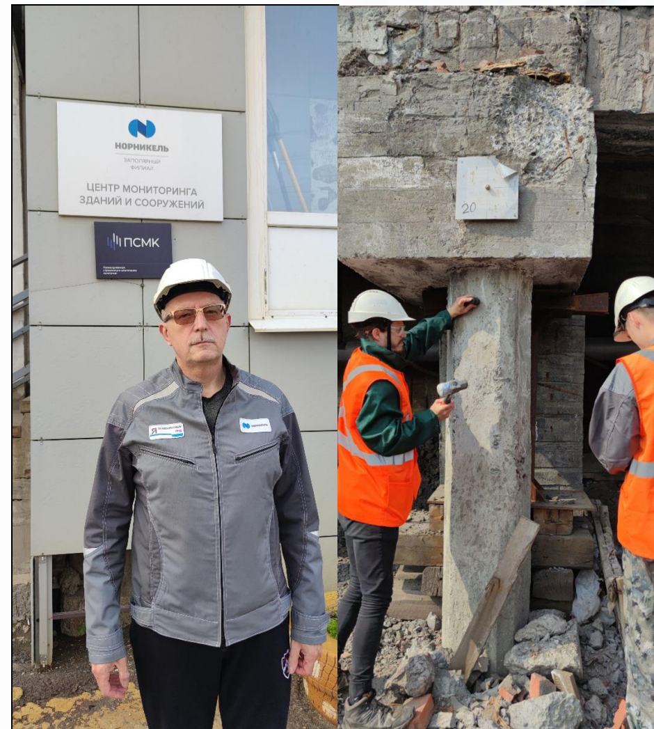
Обследование с помощью волновых методов неразрушающего контроля зданий и сооружений в Норильске
