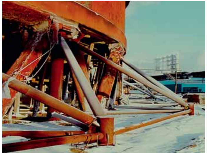
2 Опорная система крупногабаритной вентиляторной градирни СК-1200 на ОАО «Нижнекамскнефтехим», разработанная и реализованная при участии Н. М. Якупова (патент РФ № 2196209)
