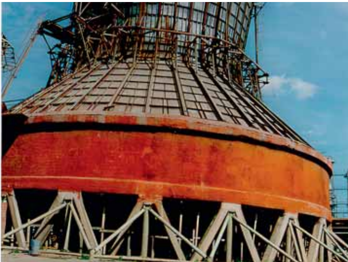
2 Опорная система крупногабаритной вентиляторной градирни СК-1200 на ОАО «Нижнекамскнефтехим», разработанная и реализованная при участии Н. М. Якупова (патент РФ № 2196209)
